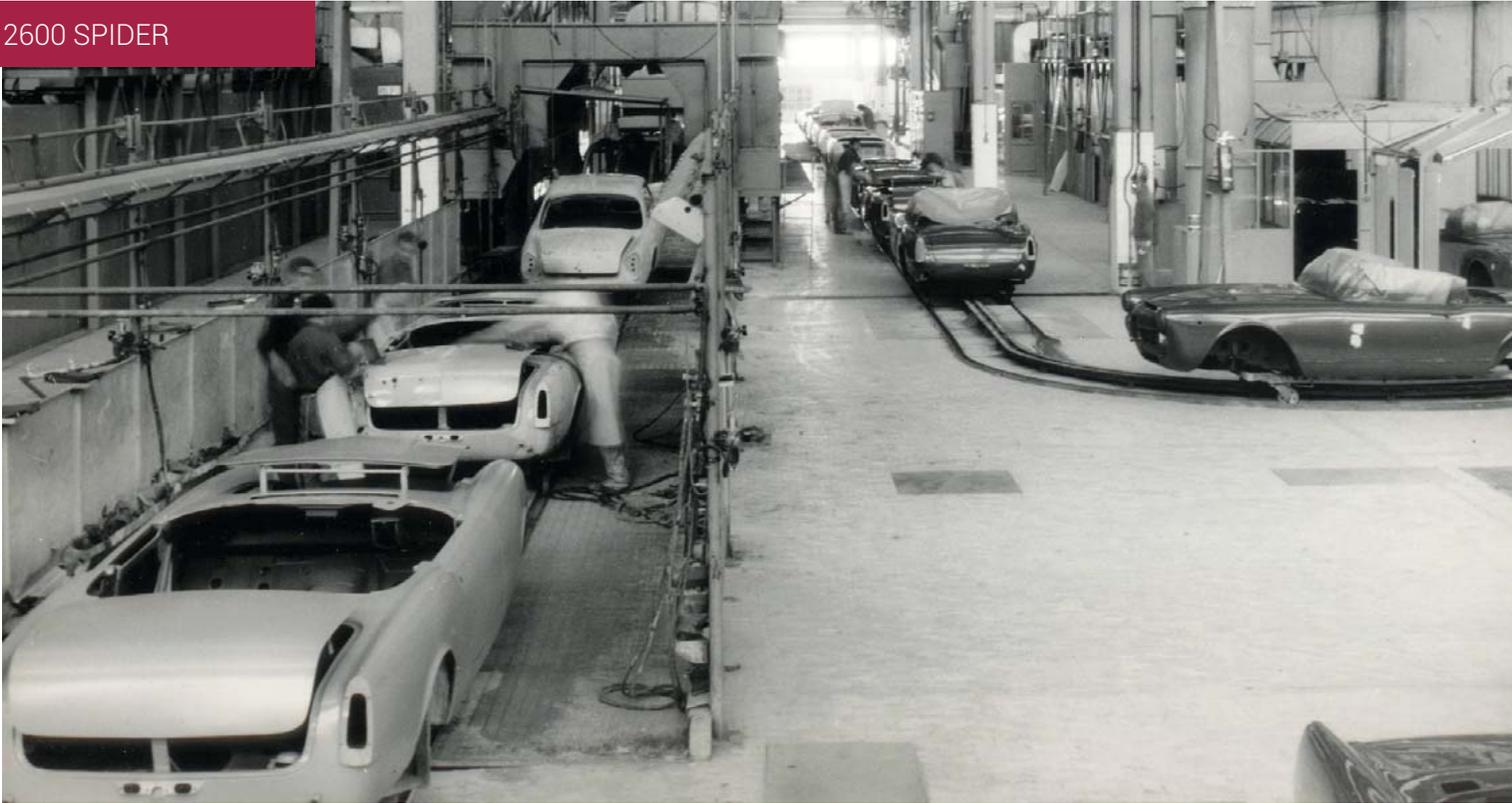
aufhängung, der Kardantunnel, die inneren Schweller, der untere Teil des Kofferraums. Wir haben dann die äußere Karosserie, also unter anderem Kotflügel, Hauben und Türen montiert.
